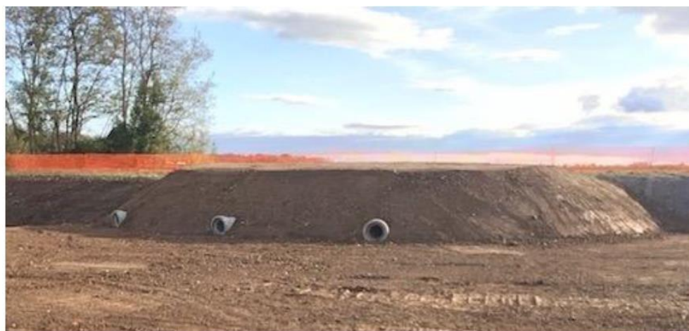
Figures 19 : Vues des travaux d'installation du terrier artificiel terminé (Source : SNCF Réseau)
